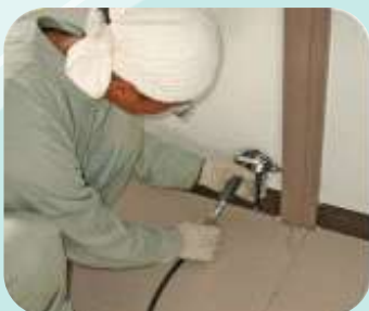
加圧注入処理
