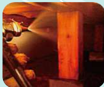
床下木部処理
